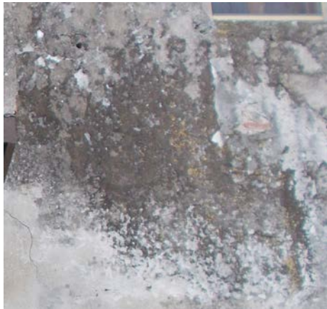
F - esempio di incrostazione in facciata
