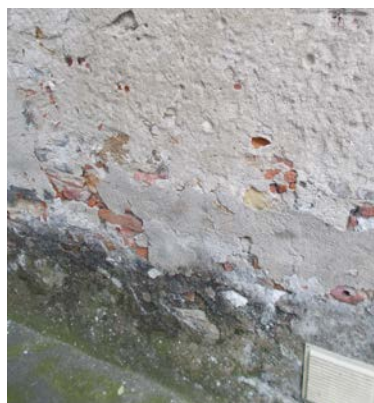
B - esempio di disgregazione in facciata
