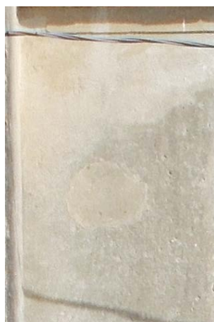
A - esempio di alterazione cromatica in facciata
