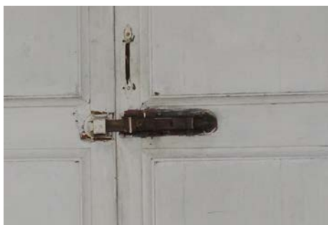
Figura 23: esempio di chiusura di porta interna
