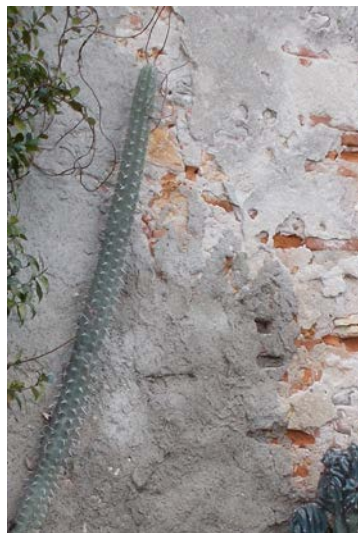
D - esempio di erosione in facciata
