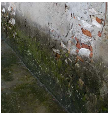
L - esempio di deposito superficiale in facciata
