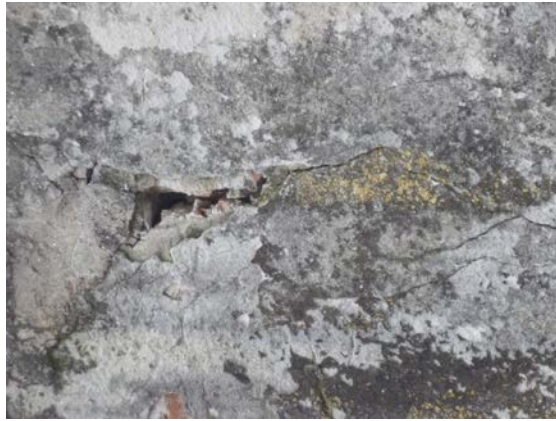
C - esempio di distacco in facciata
