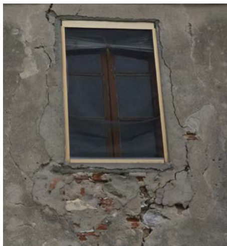
M - esempio di fessurazione in facciata
